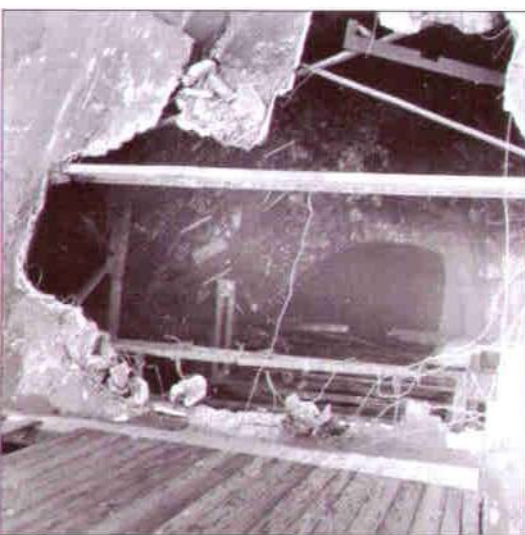
Bild 17 - Zerstörtes Stahlbetondach über dem 520m tiefen Schacht II
