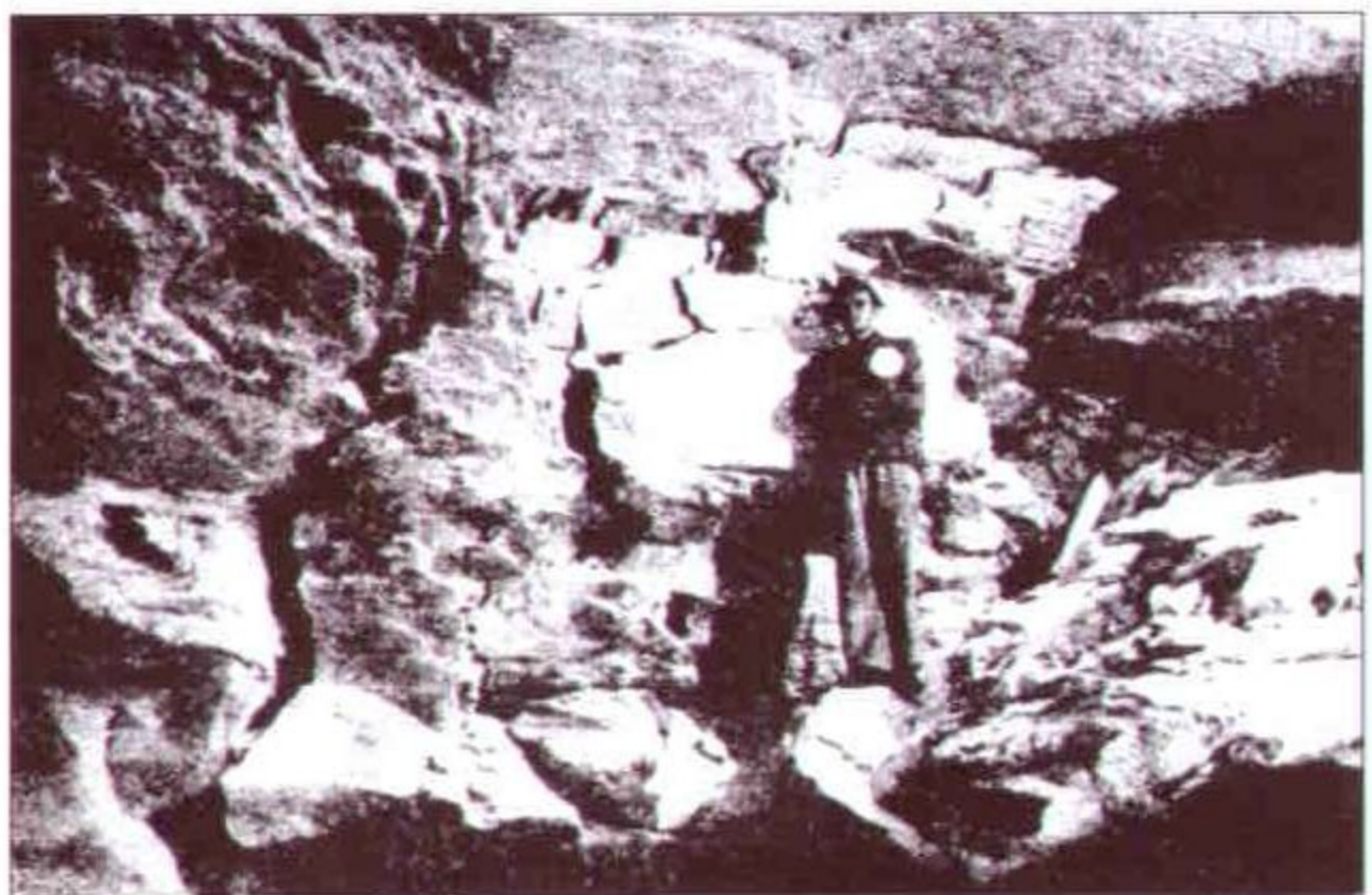
Bild 16 - Durch den Gasgebirgsschlag zerstörter Abbaupfeiler
